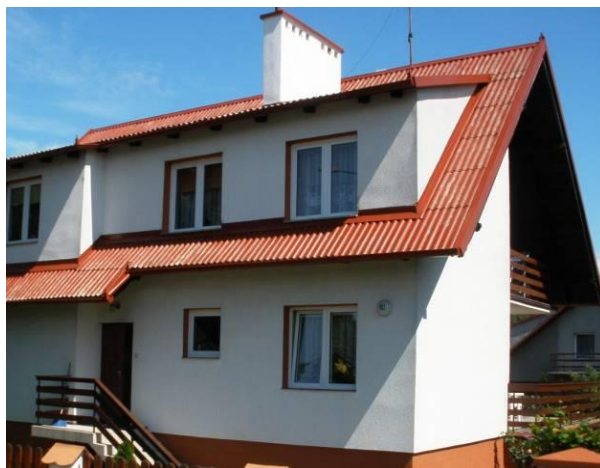
Rys. 5. Przykład zabezpieczenia wykonanego powłoką malarską.
