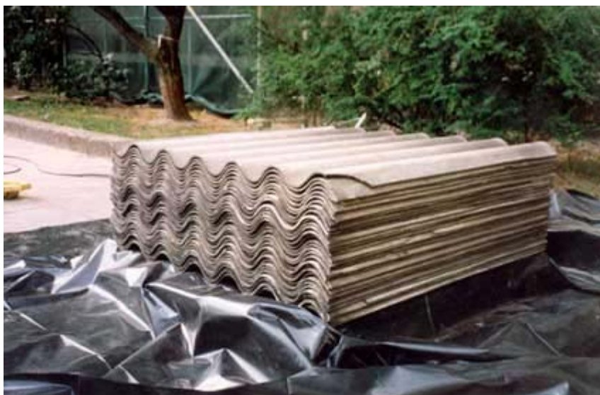
Rysunek 4 Przygotowanie wyrobów azbestowych do transportu:
